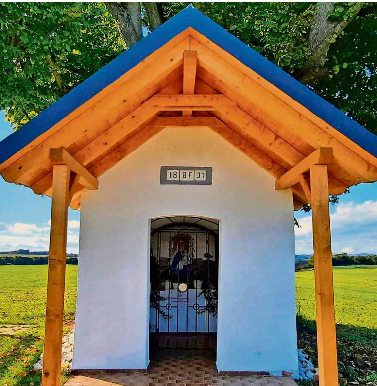
Frisch saniert strahlt die „Ropperts Kappel“ jetzt wieder im ganz neuen Glanz. Ein ganz besonderes Lob für die Arbeiten geht dabei an die Mitarbeiter des städtischen Bauhofs.
