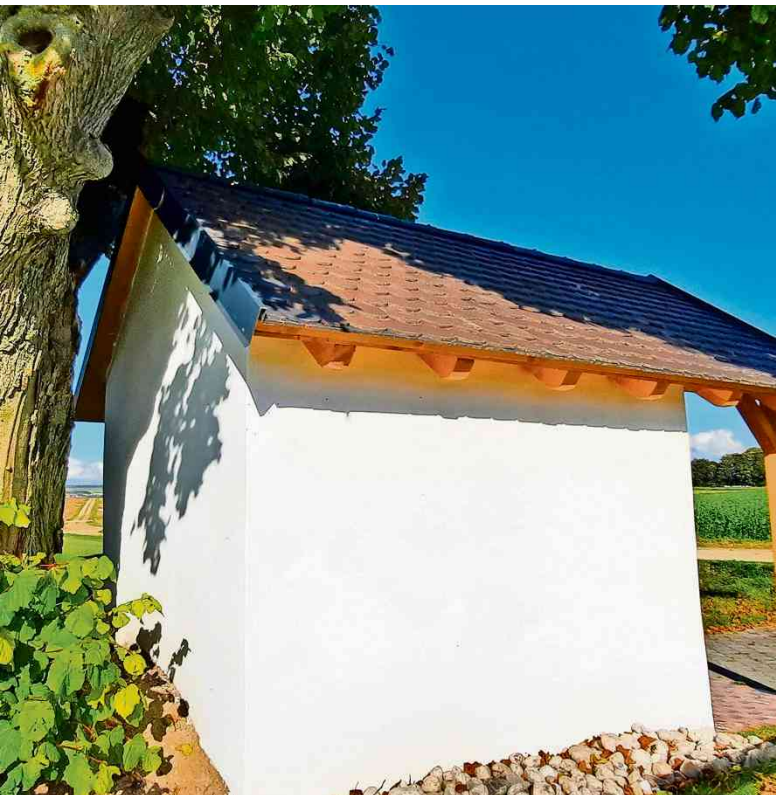
Die Kapelle wurde mithilfe eines betonierten Ringankers stabilisiert. Auch die großen Äste der Linde sind mit Gurten befestigt worden, um künftige Schäden zu vermeiden.
