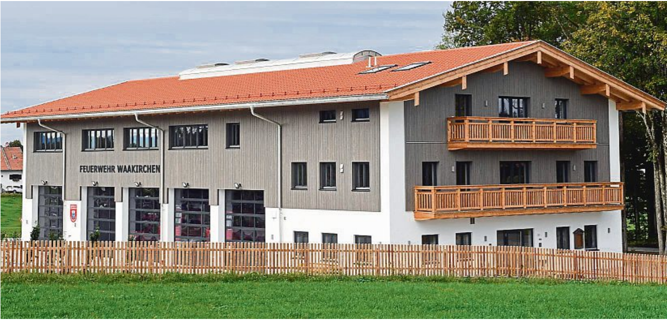
Das Dach des neuen Feuerwehrhauses soll mit einer PV-Anlage belegt werden. Um die richtige Größe zu ermitteln, will Bürgermeister Norbert Kerkel den Verbrauch analysieren. Das sogt für Zündstoff.
