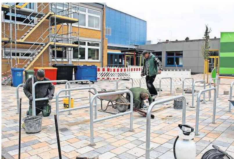
Arbeiter sind dabei, im Eingangsbereich der Grundschule Fahrradständer und -bügel für die Verkehrsmittel der Schüler zu installieren. FOTO: MELLANIE CAGLAR
