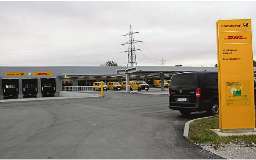
Der neue Verbund-Zustellstützpunkt der Deutschen Post AG in Habach ist einer der größten seiner Art im gesamten Bundesgebiet.
