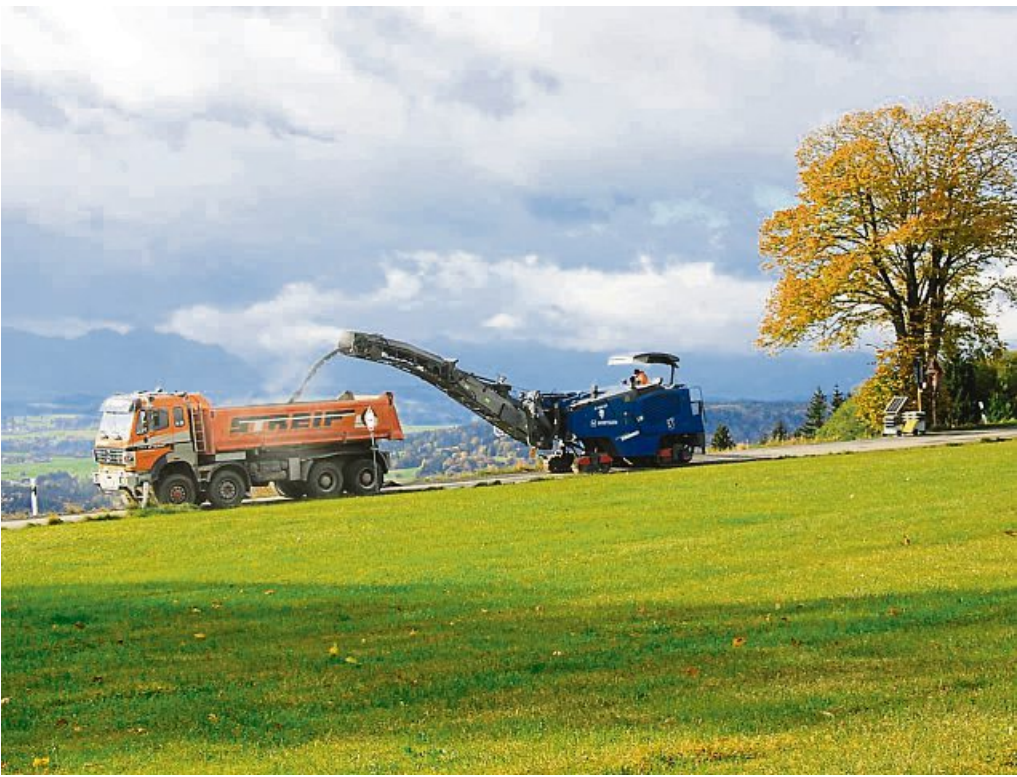
Der alte Straßenbelag der Bergstraße wurde vergangene Woche im Oberen Bereich abgefräst. Nun soll ein neuer Belag aufgebracht werden.
