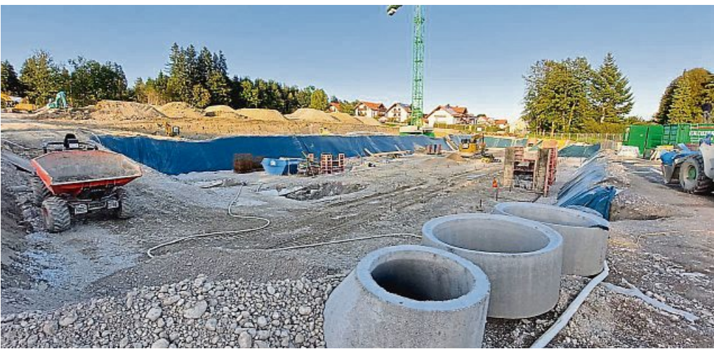
Die Baugrube für den ersten Wohnblock ist westlich der Birkenstraße bereits ausgehoben. Dieses erste Haus soll im Sommer 2023 fertiggestellt sein.
