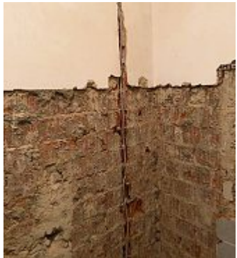
Während der Arbeiten kam die Backsteinmauer zum Vorschein.
