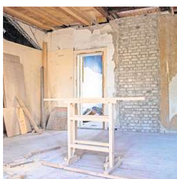
Die Wohnungen in dem Gründerzeit-Haus sind entkernt, der weitere Ausbau ist nun Sache der Käufer. FOTO: SINA SCHULDT/DPA
