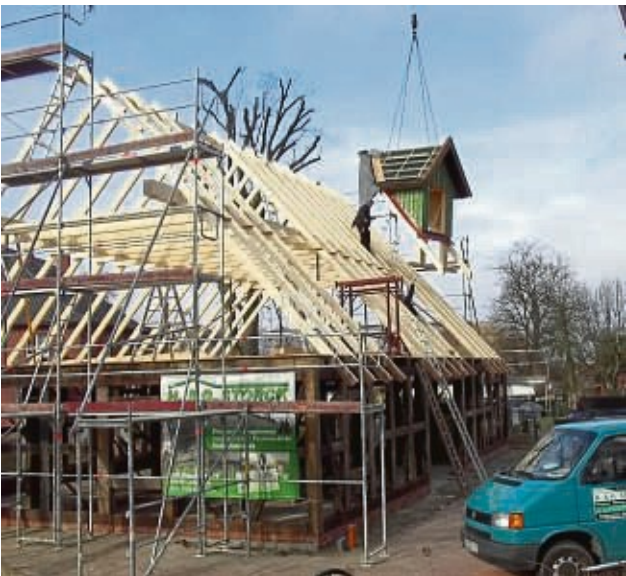
Der neue Dachstuhl des Dorfgemeinschaftshauses in Hüde wird gekrönt mit dem Einbau der vorgefertigten Erker. Richtfest wurde im März 2006 gefeiert.
