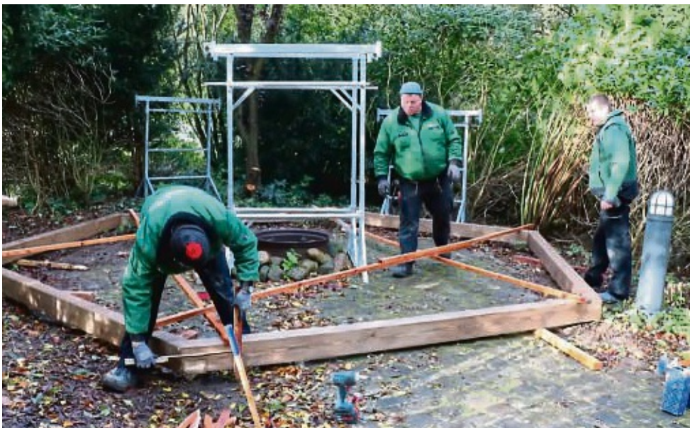
Errichten den Grillpavillon: Mitarbeiter der Firma Otto Westendorf.
