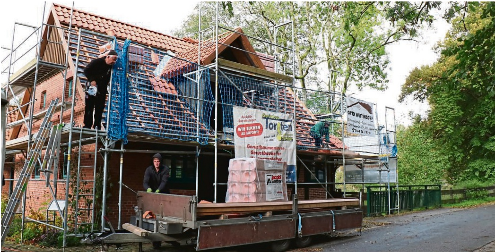
Bekommt ein neues Dach: die Wassermühle in Ostrittrum.
