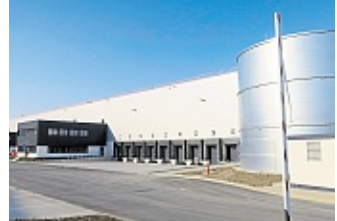
Im April eröffnete B+S quasi zu seinem 20. Geburtstag einen 30 000 Quadratmeter umfassenden Hallenneubau in Borgholzhausen. Foto: Alexander Heim
