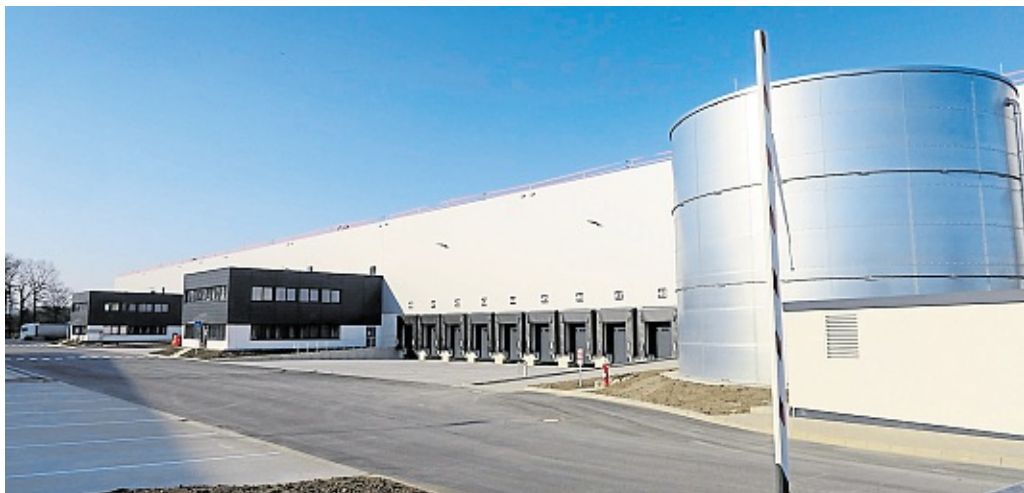
Im April eröffnete B+S quasi zu seinem 20. Geburtstag einen 30 000 Quadratmeter umfassenden Hallenumbau in Borgholzhausen.
