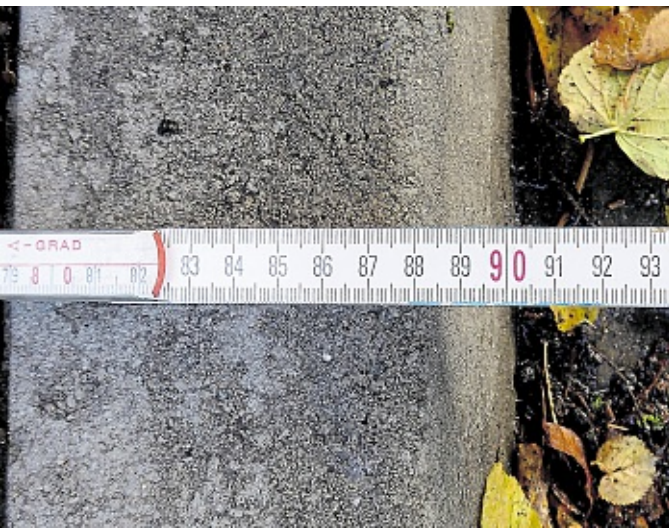
Nur 90 Zentimeter breit ist der Fußweg östlich der Landwehrstraße auf einigen Metern. Zu eng für Fußgängerbegegnungen.
