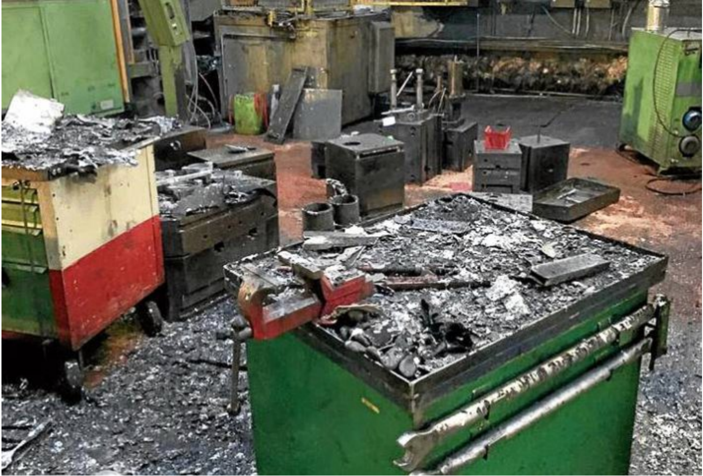
Schadensaufnahme kurz nach dem Brand bei Schlicht Druckguss in Holzminden.
