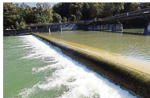
An dem Wehr kann eine Wasserwalze entstehen.
