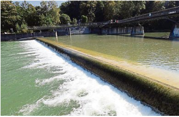
An dem Wehr kann eine Wasserwalze entstehen.
