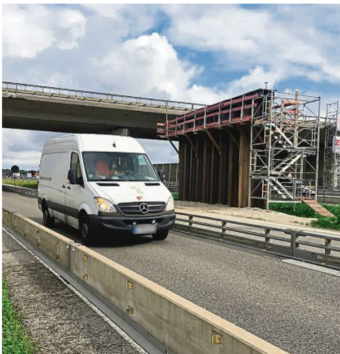
Vorsicht, Bauarbeiten. An der A 99 bei Kirchheim wird im Zuge des achtspurigen Ausbaus eine Behelfsbrücke eingehoben.
