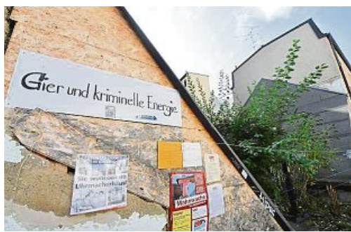
Wo seit vier Jahren eine Baulücke klafft ...
