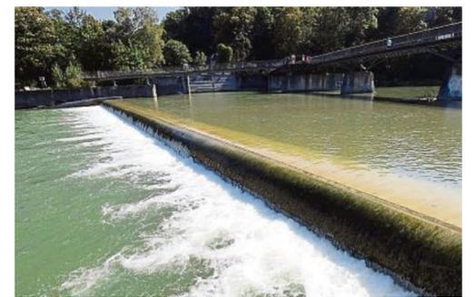
An dem Wehr kann eine Wasserwalze entstehen.
