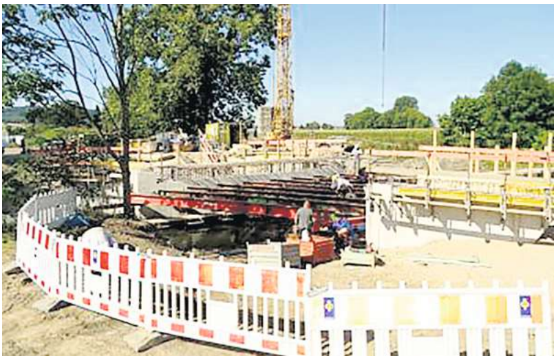
Die Arbeiter installieren die Stahlträger der neuen Brücke. FOTO: GUIDO SCHOLL
