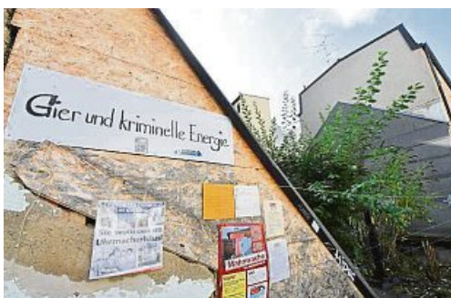
Wo seit vier Jahren eine Baulücke klafft ...
