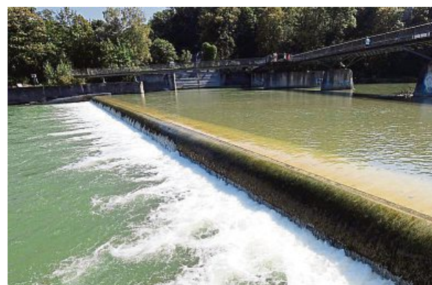
An dem Wehr kann eine Wasserwalze entstehen.
