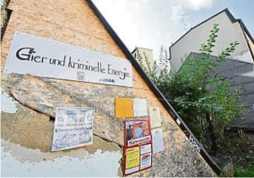
Wo seit vier Jahren eine Baulücke klafft ...
