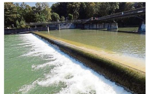
An dem Wehr kann eine Wasserwalze entstehen.
