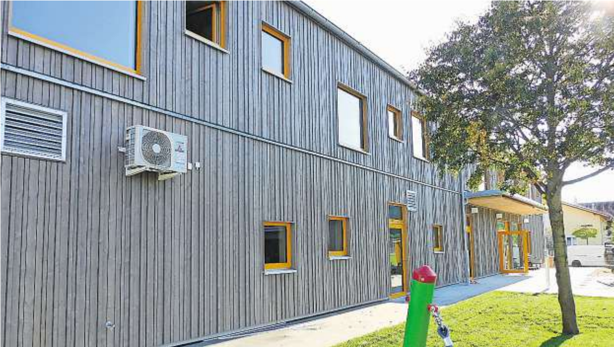
Auch wenn die Außenanlagen noch nicht fertig sind, werden ab Montag die ersten Kinder betreut FOTOS: PETRA SCHMID
