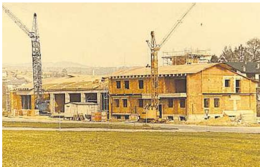
Der Rohbau ist im Entstehen. Die Fertigstellung des Feuerwehrzentrums folgte dann 1981.
