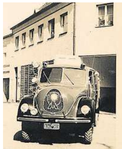
Bis 1981 Heimat der Feuerwehr Kötzting: das Gerätehaus an der Brandstraße.
