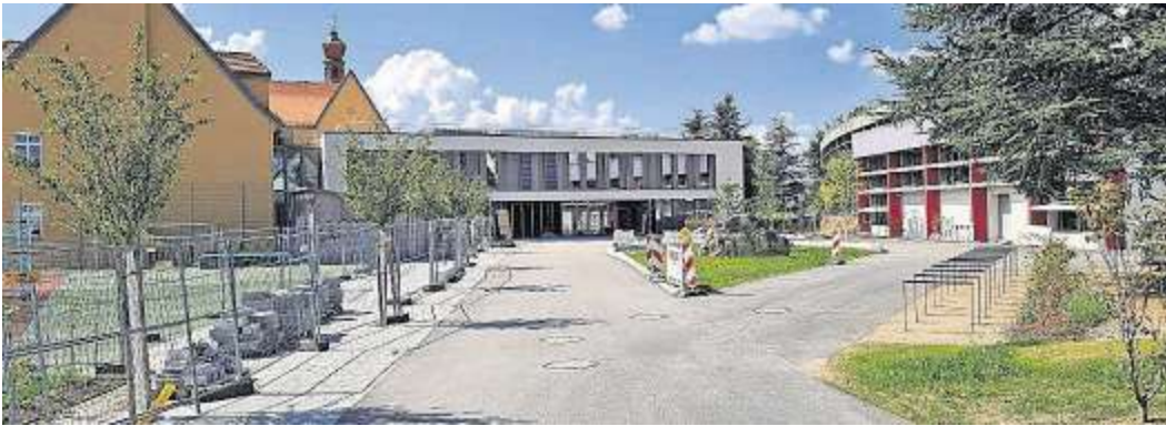
Der neue Haupteingang der Marienrealschule am Chamer Schulberg
