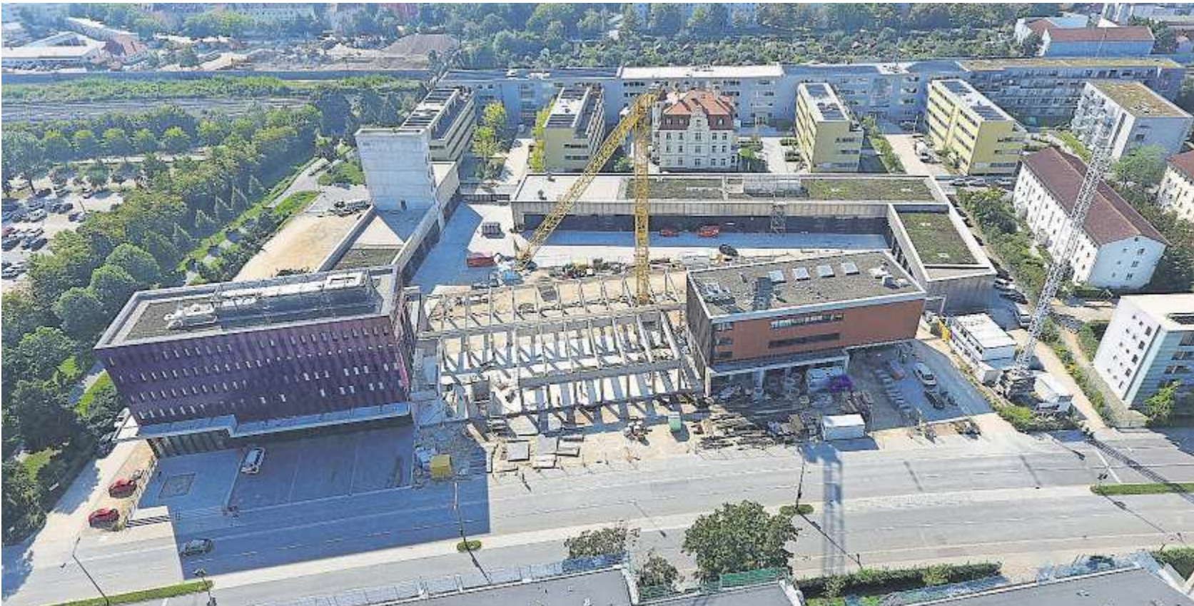
Die Baustelle in der Mitte ist deutlich sichtbar: Hier entsteht Teil zwei der Fahrzeughalle, obendrauf werden zwei Stockwerke gebaut. Damit wird das Mittelgebäude genauso hoch wie die Leitstelle (rechts).
