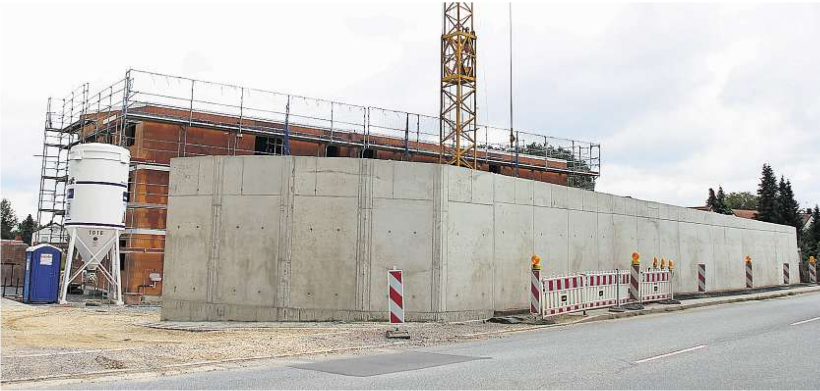
Im Baugebiet „An der Gärtnerei“ in Köfering entstehen vier Mehrfamilienhäuser mit jeweils zwölf Wohnungen. Zur Hauptstraße wurde eine drei Meter hohe Lärmschutzwand errichtet. FOTO: LOUISA KNOBLOCH
