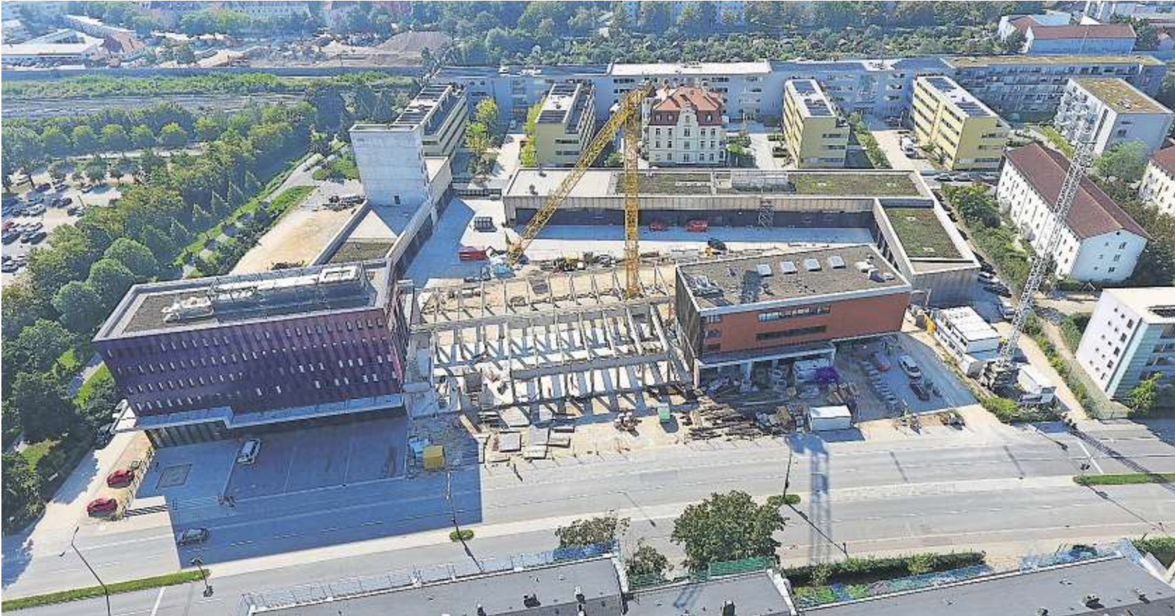
Die Baustelle in der Mitte ist deutlich sichtbar: Hier entsteht Teil zwei der Fahrzeughalle, obendrauf werden zwei Stockwerke gebaut. Damit wird das Mittelgebäude genauso hoch wie die Leitstelle (rechts). FOTO: TINO LEX
