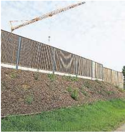
Entlang der Ostumgehung von Neutraubling besteht der Lärmschutz aus einem begrünten Erdwall und darauf einer mit Holz verkleideten Wand. FOTO: LOUISA KNOBLOCH
