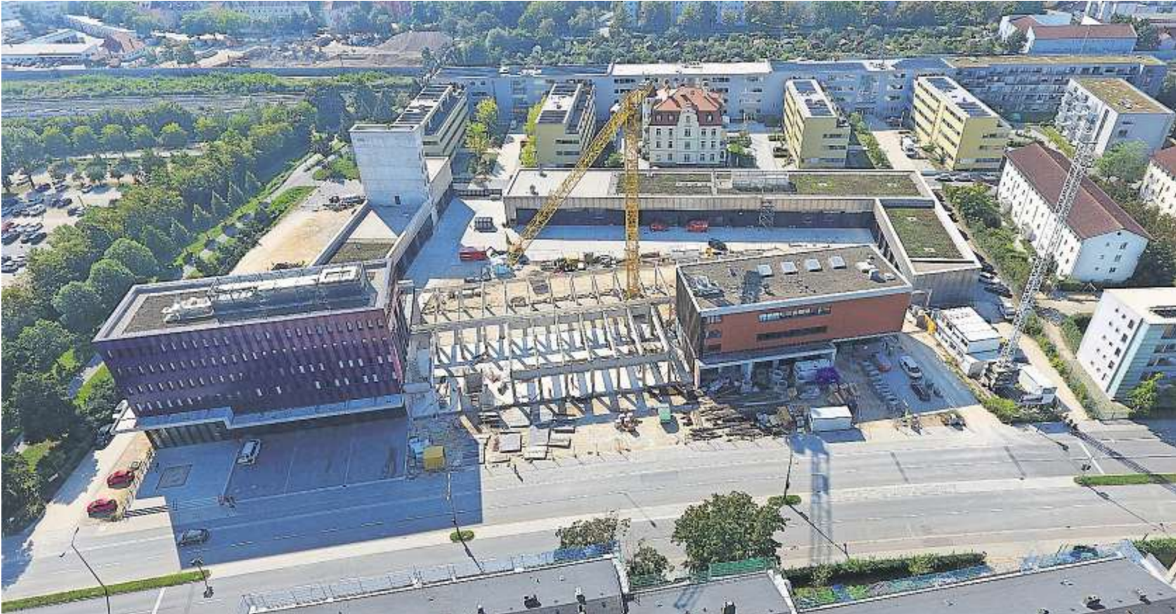
Die Baustelle in der Mitte ist deutlich sichtbar: Hier entsteht Teil zwei der Fahrzeughalle, obendrauf werden zwei Stockwerke gebaut. Damit wird das Mittelgebäude genauso hoch wie die Leitstelle (rechts).
