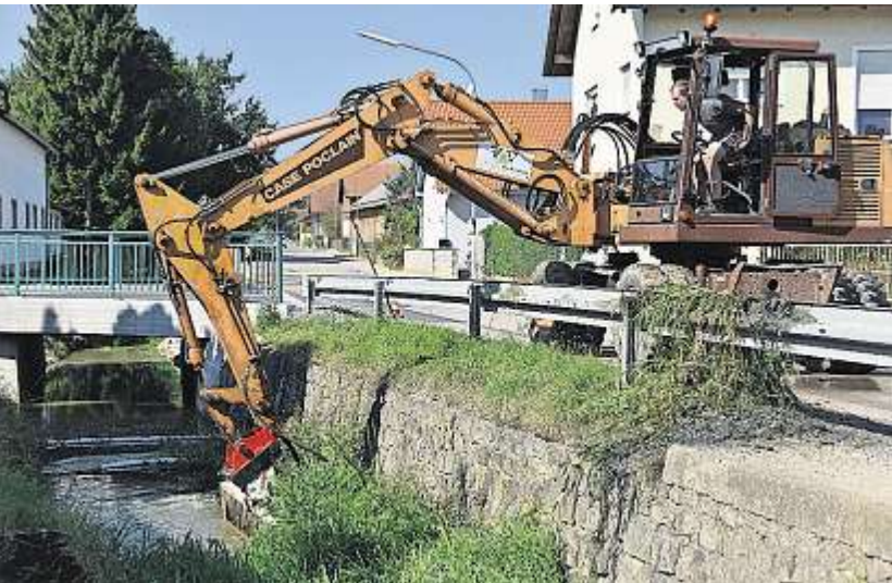
Hier befreit der Bagger den Bach von seinem krautigen Bewuchs. FOTO: EDER
