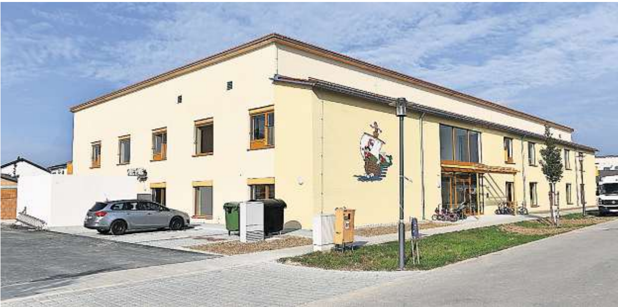
Der neue Kindergarten ist trotz einiger Probleme in der Bauphase rechtzeitig in Betrieb gegangen. FOTO: TINO LEX
