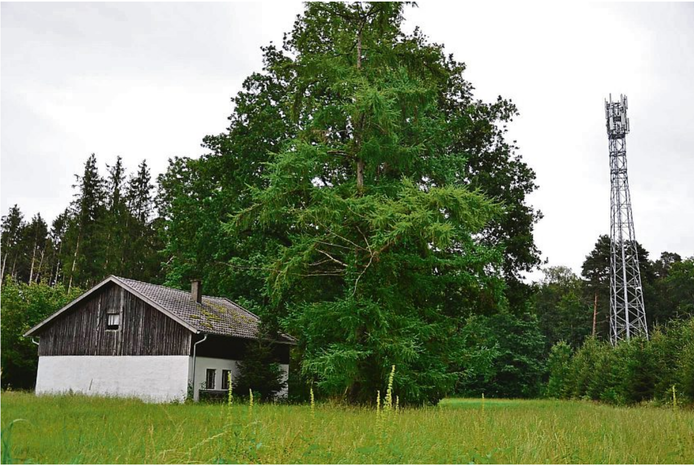
Seit bald fünf Jahren in Betrieb ist der Bucher Mobilfunksendemast im Hausmehring Wald. Links im Bild das einsam gelegene Fischbacherhäuschen.
