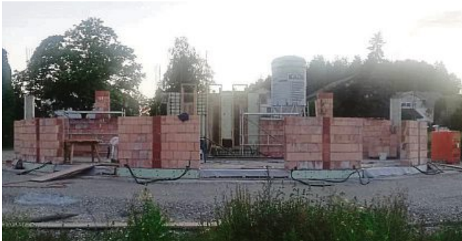
Die ersten Mauern der neue Aussegnungshalle in Rott nördlich der Kirche zur Heiligen Familie stehen bereits. FOTO: HALMEL
