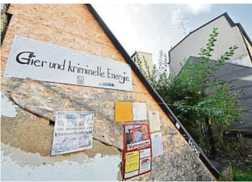
Wo seit vier Jahren eine Baulücke klafft ...
