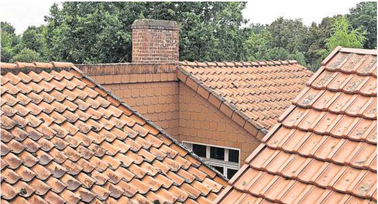
Auf historischen Duderstädter Dächern dürfen keine Solaranlagen montiert werden. FOTO: NADINE ECKERMANN
