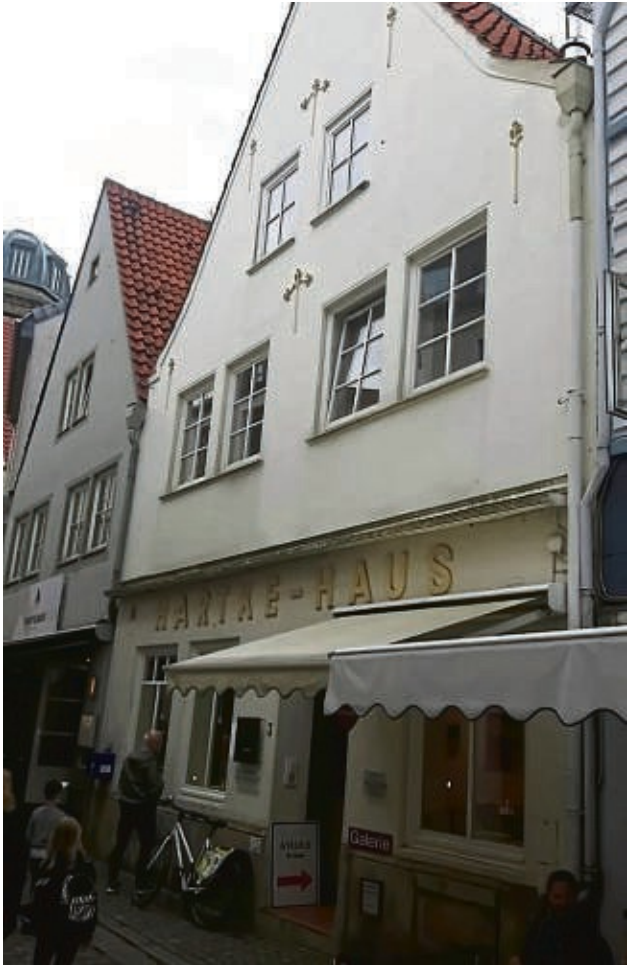
Größtenteils im alten Stil wiederaufgebaut: das Hartke-Haus, Am Landherrnamt.
