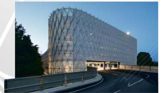
**Das Messeparkhaus.** 2018 fertiggestellt, lobte die Kölnmesse aufgrund der prominenten Lage 2015 einen „Design and Build“ Wettbewerb“ aus. Das Stuttgarter Büro „Wulf Architekten“ hat dafür eine vorgehängte Fassade aus Metallschuppen mit über 3000 Einzelelementen entworfen.
