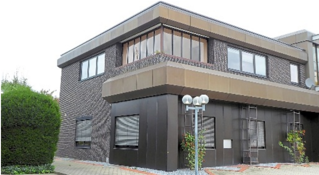
An mehreren Stellen hinter der südlichen, oberen Verkleidung der einstigen Volksbank in Alt-Lotte hatten Fledermäuse ihre Kinderstuben.
