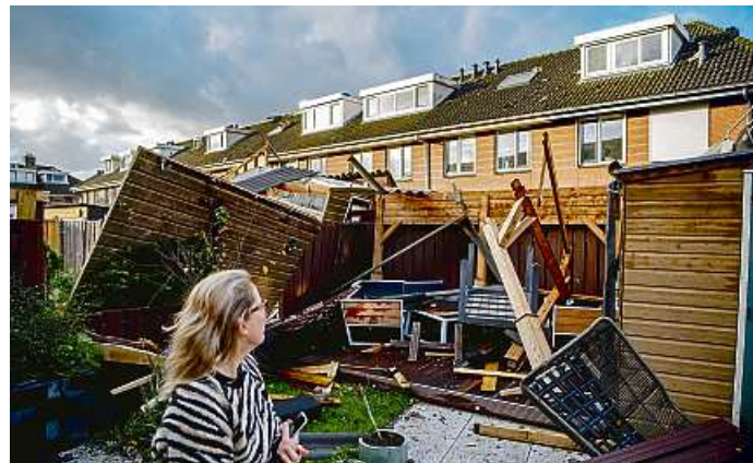
Im niederländischen Barendrecht steht eine Frau vor ihrem beschädigten Haus im Wohngebiet Ter Leede. Foto: Robin Utrecht/ANP/dpa
