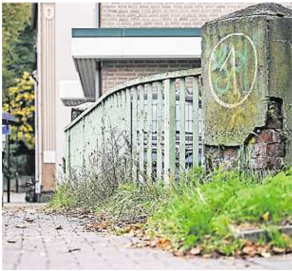
Die Rotbachbrücke an der Sterkrader Straße soll saniert werden.
