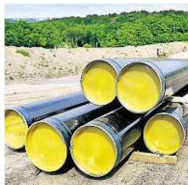
Die Firma Open Grid Europe verlegt verschiedene Gas-Pipelines.
