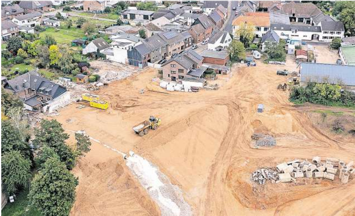
Das Wasser des Flusses Erft suchte sich den Weg durch den Ort und riss Häuser, Bäume und Fahrzeuge mit (l.). Heute schaffen schwere Baufahrzeuge neuen Sand heran, mit Baggern werden die Erdvertiefungen verfüllt.
