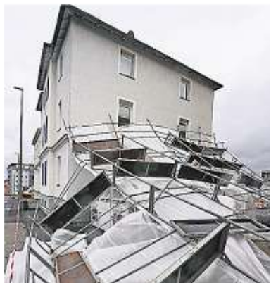
In Würzburg wurde ein Baugerüst von den Böen umgeweht.
