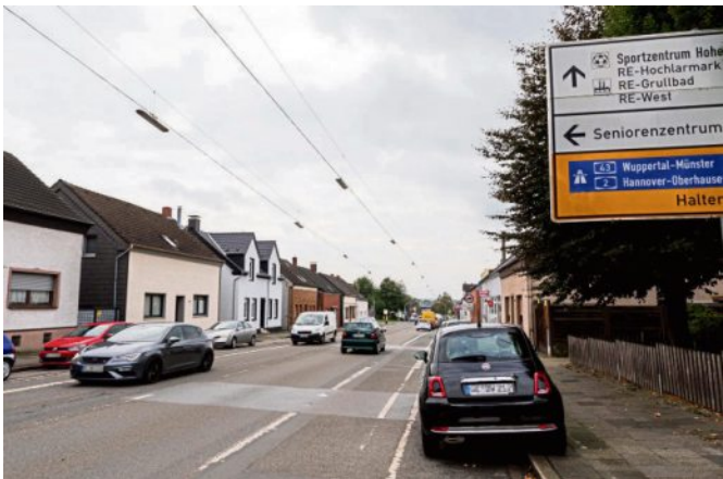
Gen Hochlarmark: der letzte Abschnitt der Straße.
