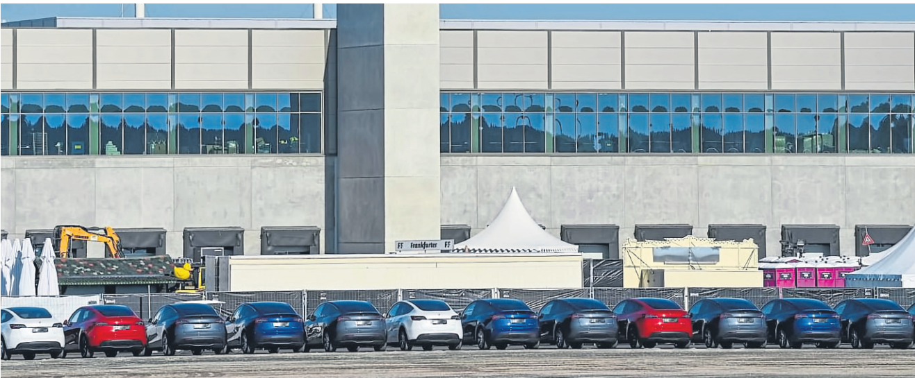
Die Baustelle der Tesla-Fabrik in Grünheide bei Berlin. Hier scheint es neue Schwierigkeiten zu geben.
