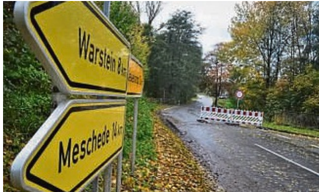
Die L 735 aus der Bache in Richtung Oeventrop wurde aufgrund der Sturmschäden gesperrt.
