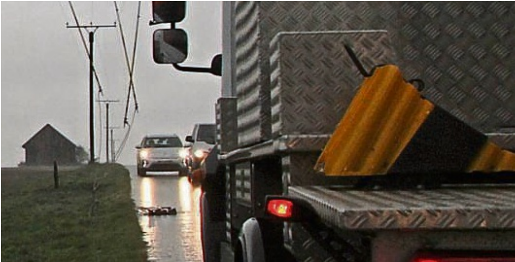
Mitarbeiter des Netzbetreibers waren am Morgen damit beschäftigt, die gerissene Stromleitung am Kneblinghauser Weg wieder instand zu setzen.
