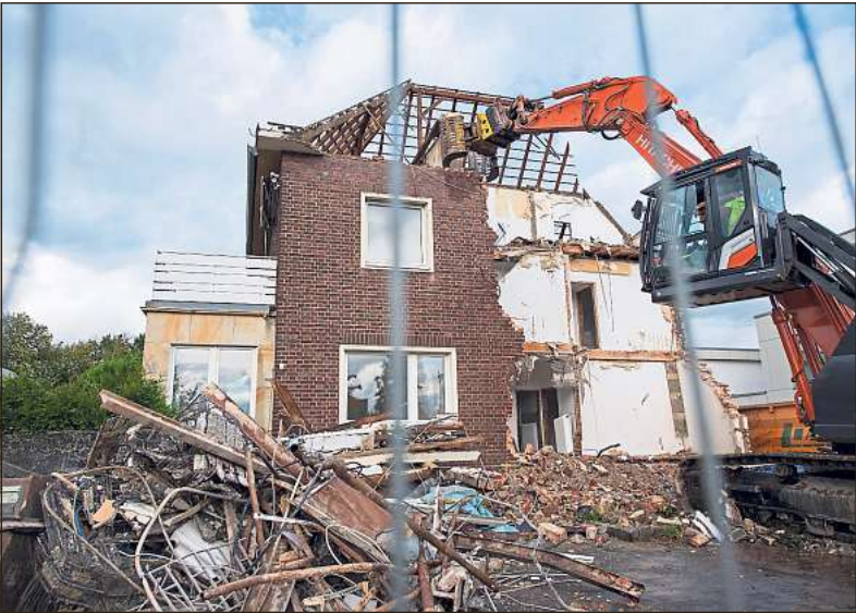
Tschüss, altes Haus: Das Kaffeemühlenhaus an der Paderborner Straße wird durch einen Neubau ersetzt. Foto: Wedel
