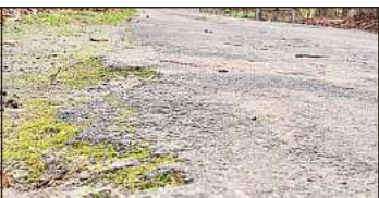
Für die Arbeiten wird der Dechant-Budde-Weg zwischen Kirchplatz und Gymnasium ab Montag gesperrt. Foto: Grund
