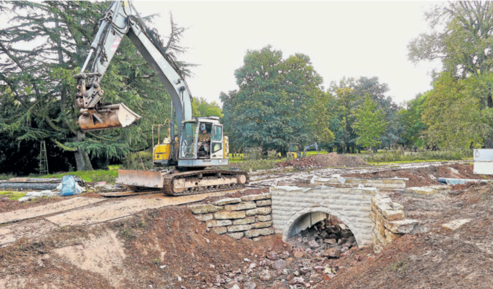
Jens Gelderblom mit dem Bagger am künstlich angelegten neuen Bachbett. Markant wirkt die fast fertige Natursteinbrücke.
