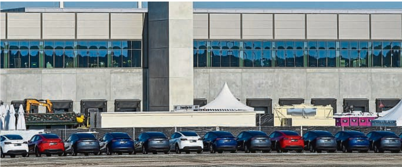
Die Baustelle der Tesla-Fabrik in Grünheide bei Berlin. Hier scheint es neue Schwierigkeiten zu geben.
