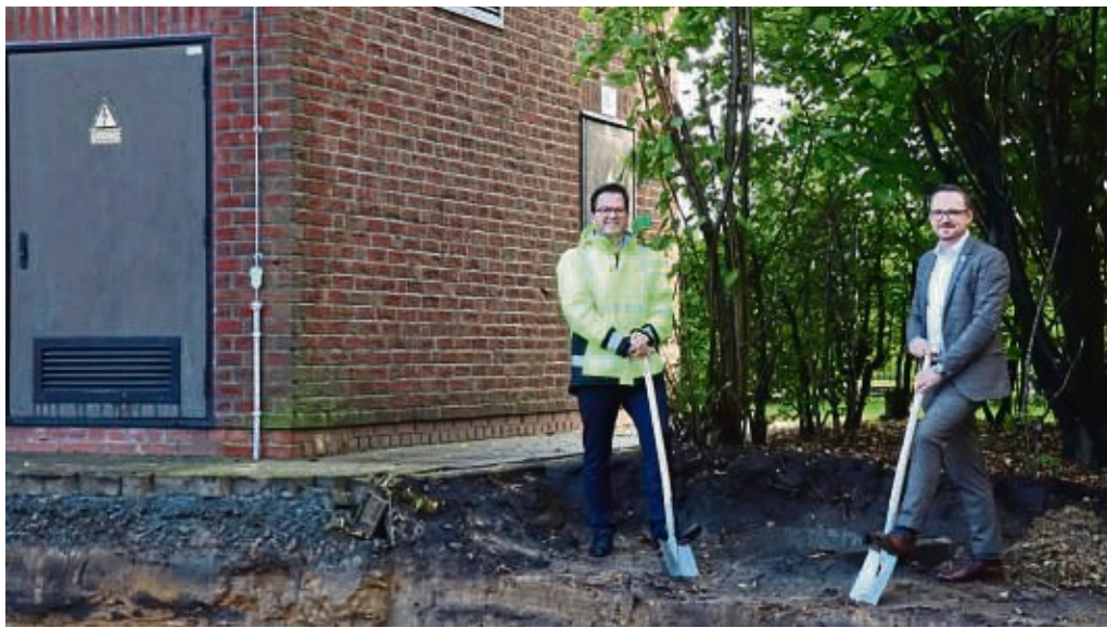
Erster Spatenstich für die neue Nahwärmeezentrale der Baugebiete Lange Wand III und I: Stadtwerkechef Matthias Partetzke (links) und der Diepholzer Bürgermeister Florian Marré.
