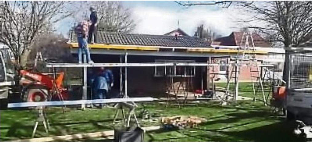
Auch einen neuen Dachüberstand errichteten die Helfer. FOTO: SV MARHORST
