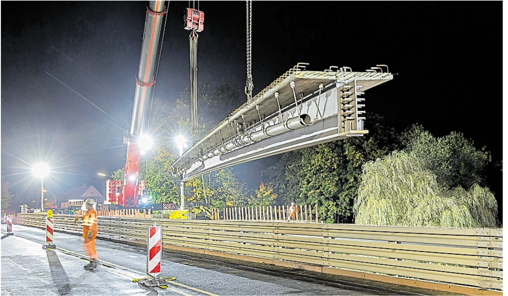
Gut zu erkennen ist der Aufbau des Trägers: der untere, senkrecht stehende Teil besteht aus Stahl. Darüber verläuft eine Betonschicht.
