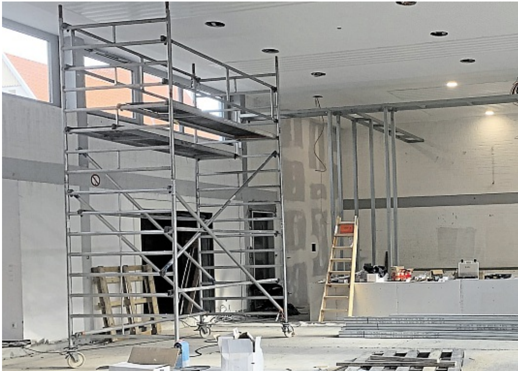
Noch ist die alte Turnhalle in Rieste eine Baustelle. Sie wird zum künftigen Mehrzweckraum an der Grundschule umgebaut. Foto: Marcus Alwes
