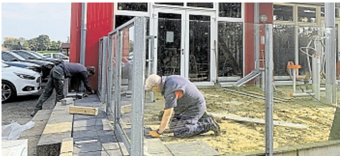
An der künftigen Fitnessterrasse am Bullermeck wird fleißig gearbeitet.
