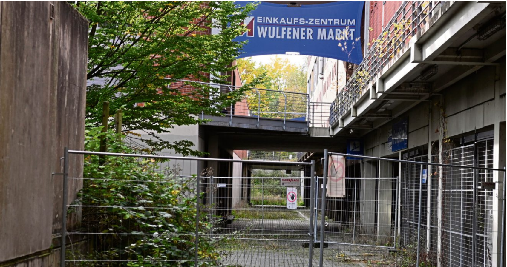
Die Tage des ehemaligen Wulfener Einkaufszentrums Wulfener Markt sind gezählt. 2022 wird es abgerissen.
