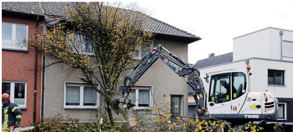
Der Baubetriebshof musste mit einem Bagger aushelfen, um den Baum zu zerlegen.
