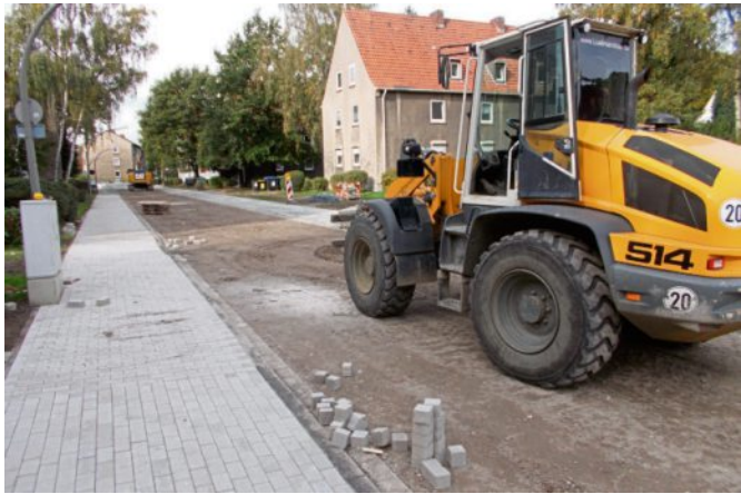
Nach der Kanalsanierung werden auch Gehwege und Straßenabschnitte erneuert. FOTO STADT MARL/ZBH
