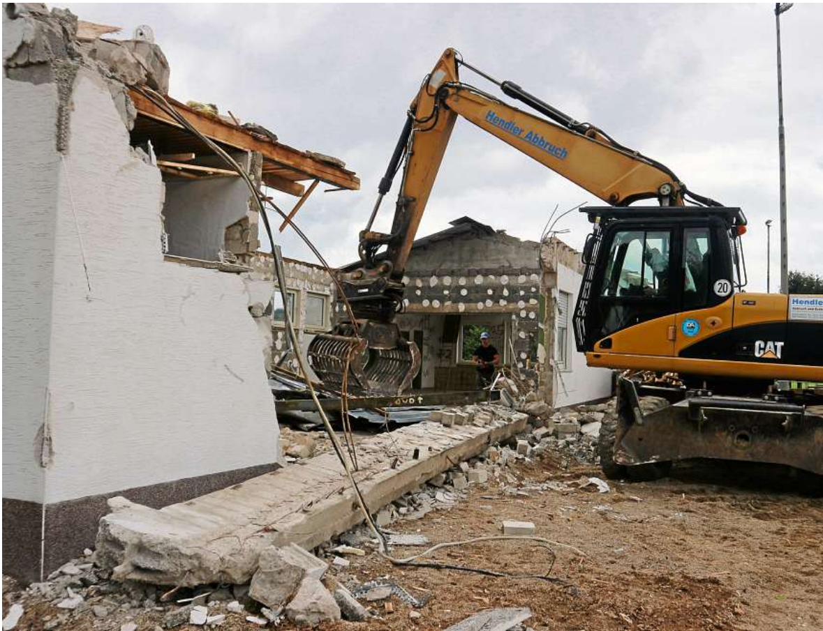
Ein Foto vom Abriss des Vereinshauses in Ostentrop-Schönholthausen. Weil das Baugrundgutachten verspätet eingetroffen ist, verzögern sich die Arbeiten für den Neubau des Breitensportzentrums.
