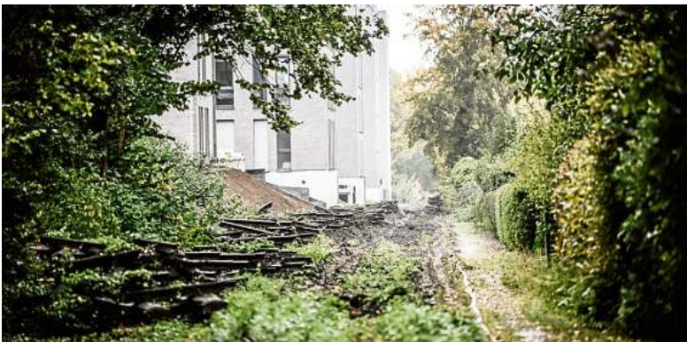
Die Arbeiten auf dem ehemaligen Rommenhöller Gleis zum Bau des Radweges schreiten voran.
