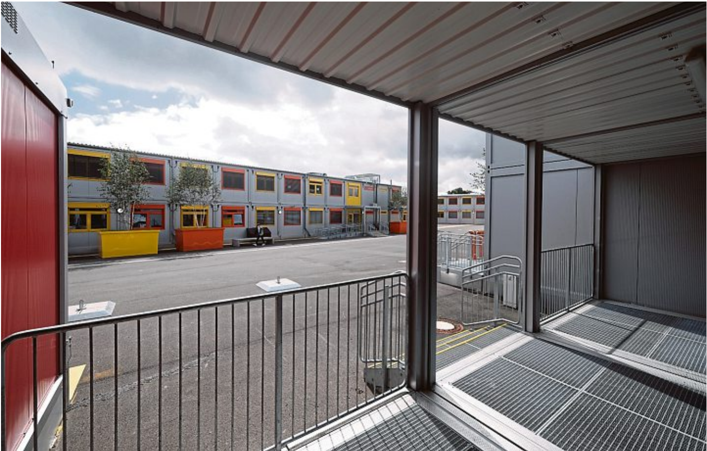
Das Dreikönigsgymnasium ist vorübergehend in einem Interimsbau, der aus Containern zusammengestellt wurde, untergebracht.
