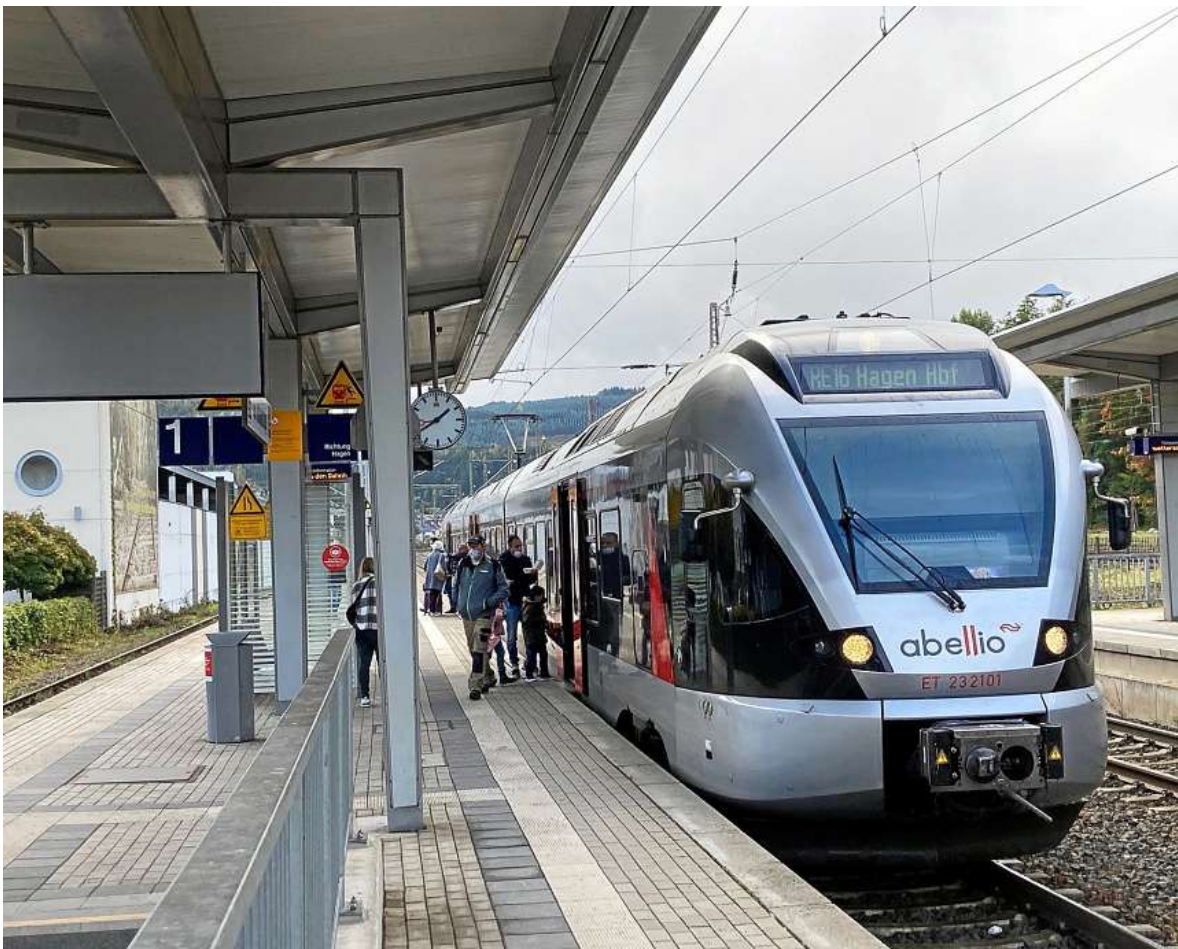
Die gesamten Modernisierungsarbeiten laufen größtenteils parallel zum Zugverkehr ab.
