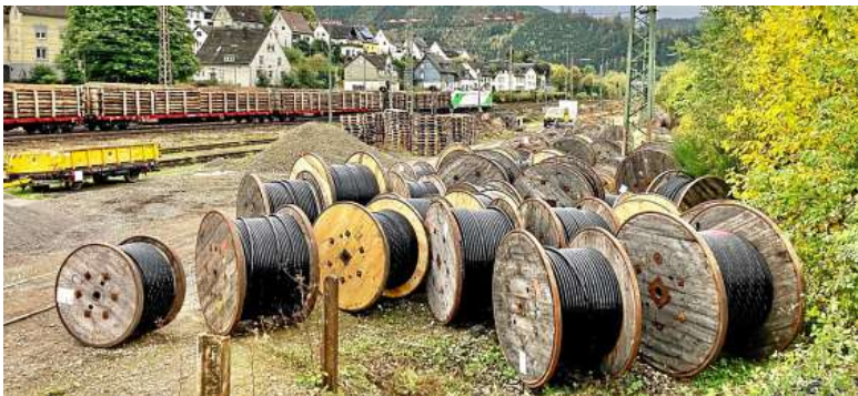
Hier wird nachts gearbeitet: Dutzende Kabelrollen türmen sich auf dem Bahngelände.
