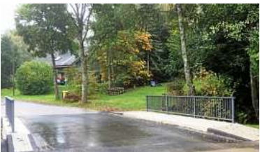
Die Brücke über die Veischeide ist wieder für den Verkehr freigegeben.
