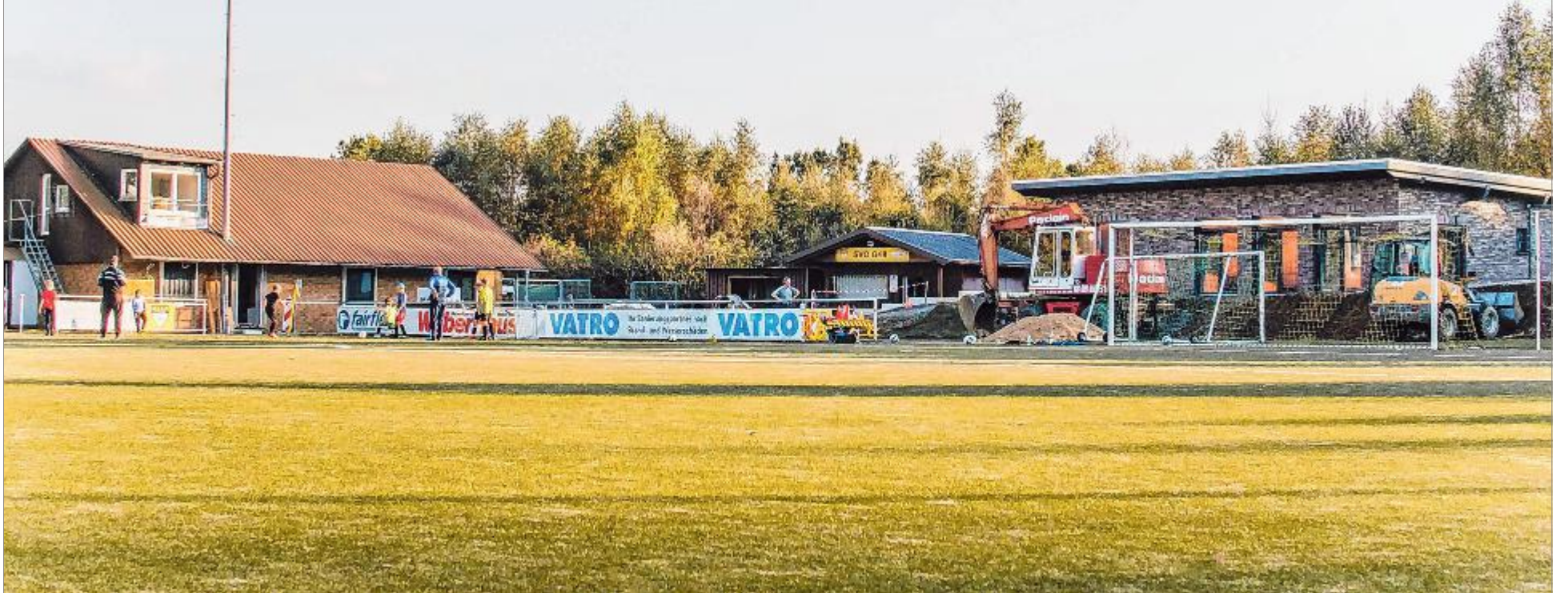
Der Altbau (l.) ist entkernt und wird zum Funktionsgebäude ausgebaut, das Clubhaus (r.) ist nun das neue Herzstück der Sportanlage am „Siepen“ und grenzt unmittelbar an den neuen Spielplatz an.
