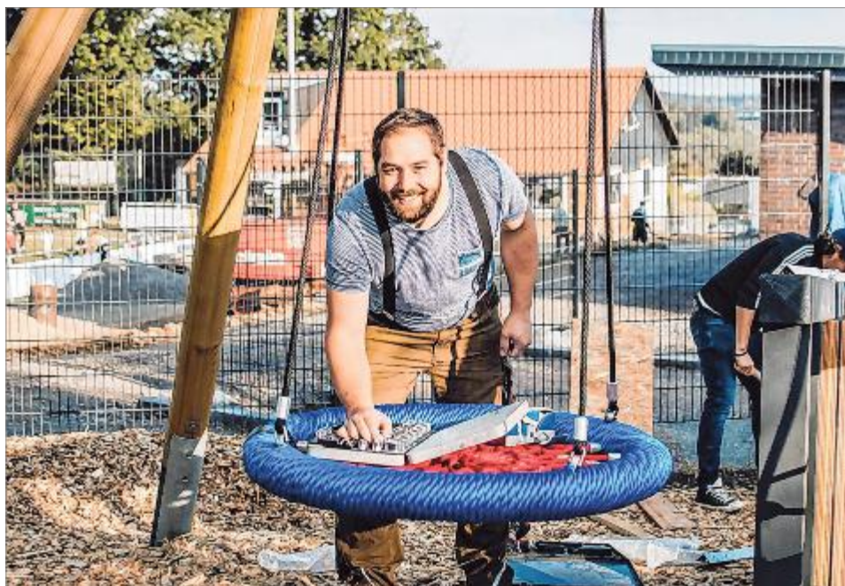
Stefan Löcker erledigt Restarbeiten auf dem neuen Spielplatz, der mit einer Terrasse eine Verbindung zum neuen Clubhaus eingeht.
