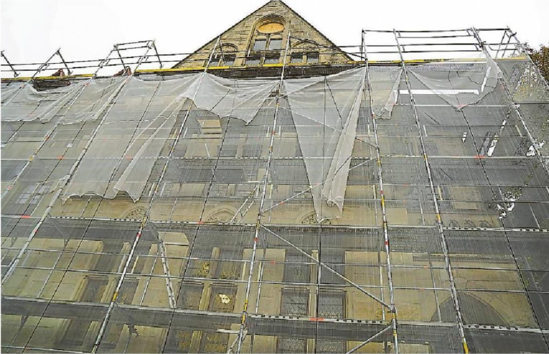
Noch ähnlich verhüllt wie ein Christo-Kunstwerk – die Fassaden- und Dachsanierung ist abgeschlossen, das Gerüst wird in Kürze wieder abgebaut.
