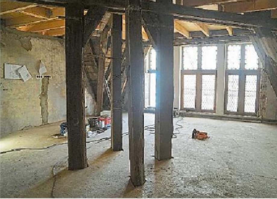
Im vierten Stock entsteht ein Mehrzweckraum für die Mitarbeiter der Stadtverwaltung.
